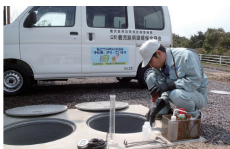
定期検査の様子
