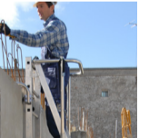
Amarrage sur banche avec crochets 384 mm en s rie
