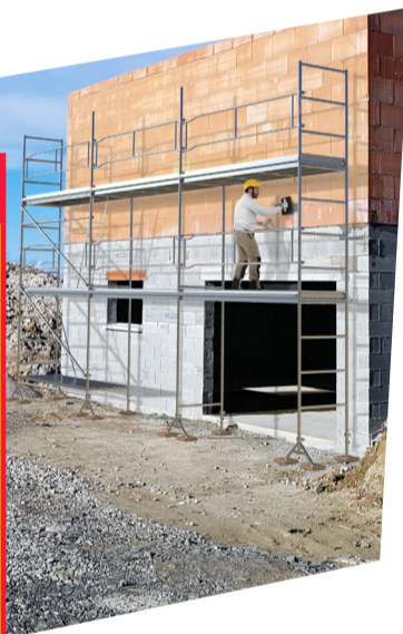
MEDIUM 80 m 2 avec plateaux acier et garde-corps monoblocs
