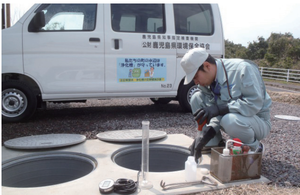
定期検査の様子
