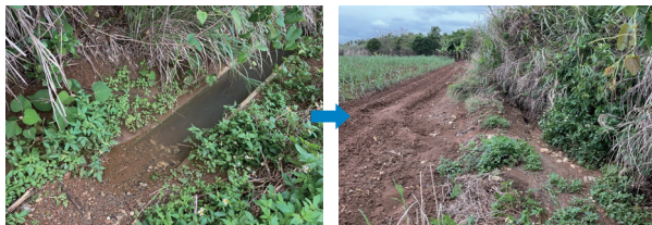
↑普段から赤土が溜まったままの側溝において、溢れた水が下の畑に被害をもたらした例
